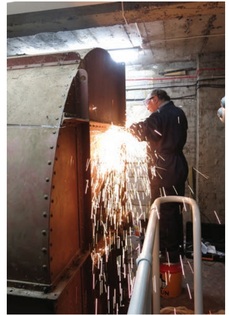
Dismantling plenum fan
