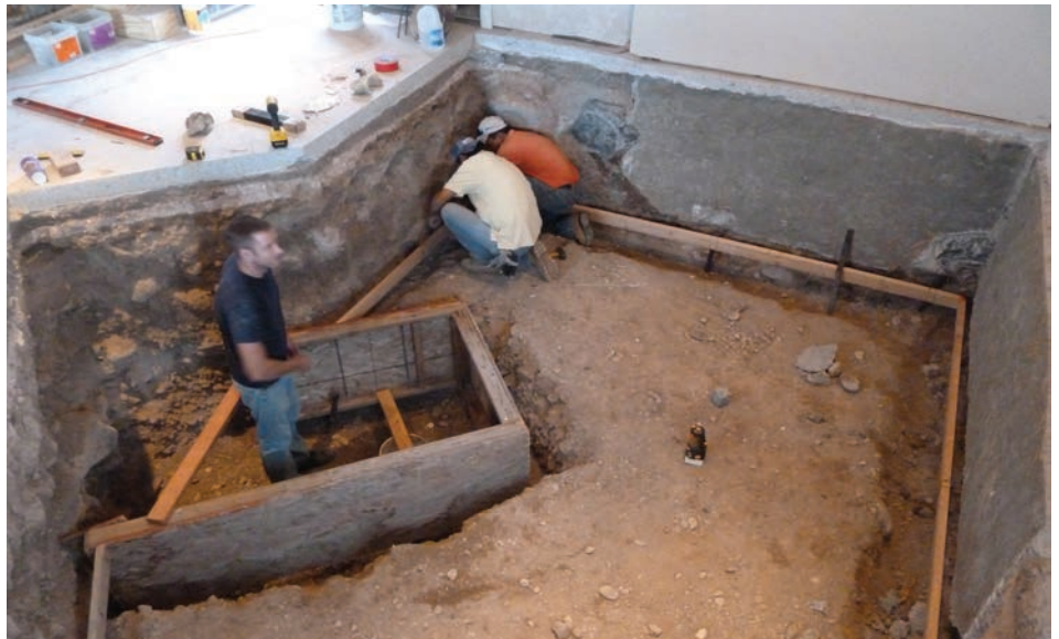
Preparing to pour the chamber floor
