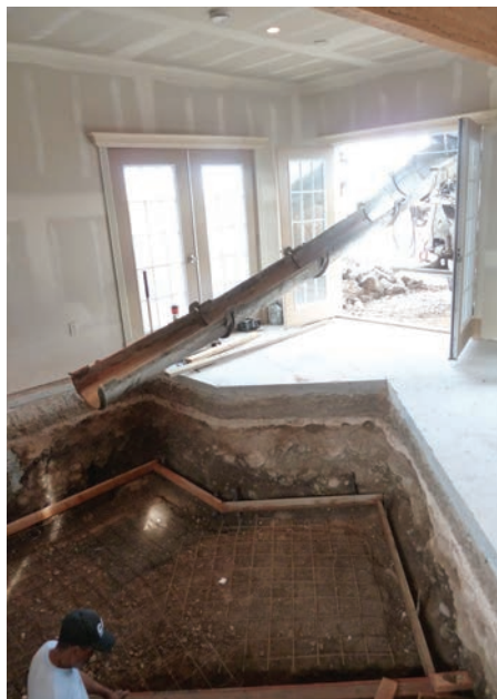
The floor pour begins
