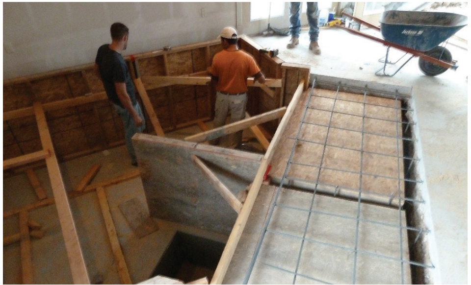
Preparing to pour the chamber floor
